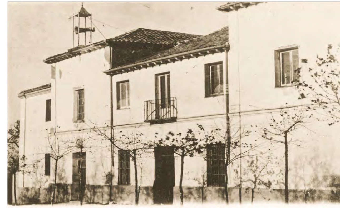
Vista de la fachada principal del convento
