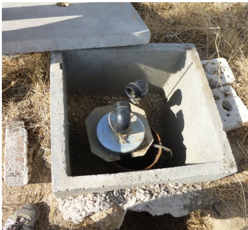
Foto 10. Pozo ubicado en la zona de la Alternativa 2
